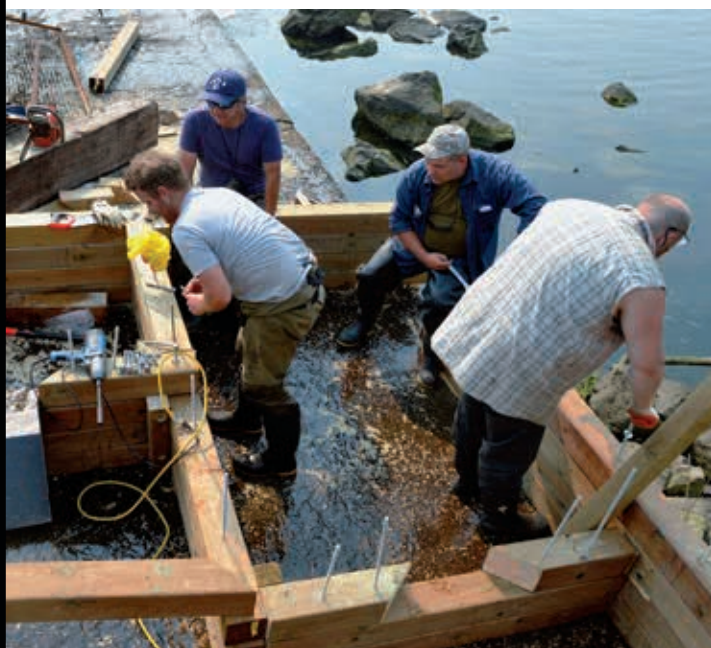
Workers retrofit an old pool-and-weir fish ladder on the Sydney River with Alaska Steep Pass type chutes. / Des travailleurs transforment l'ancienne passe à seuils déversants sur la rivière Sydney en passe à ralentisseurs de type Alaska.
