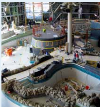
Armeringsarbetet i Sundsvalls nya äventyrsbad har varit en utmaning som heter duga. Alla former är runda.
