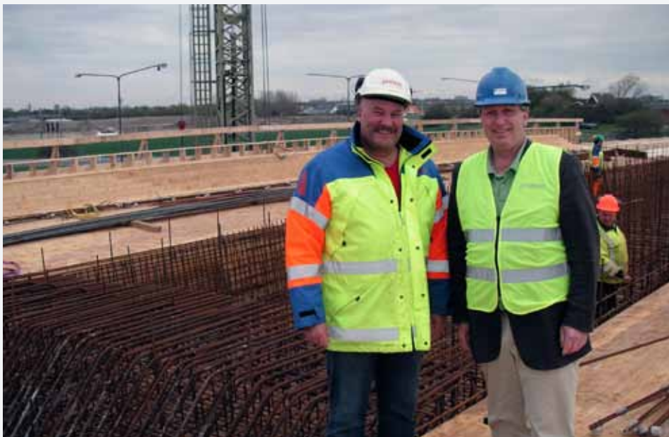
Robert Clair (vit hjälm) är Svevias ansvarige platschef för betongarbetena vid det pågående motorvägsbygget mellan Trelleborg och Vellinge i Skåne. Tibnors säljare Bertil Ekelöf har sett till att bearbetad armering levererats till alla fyra broarna på sträckan.
