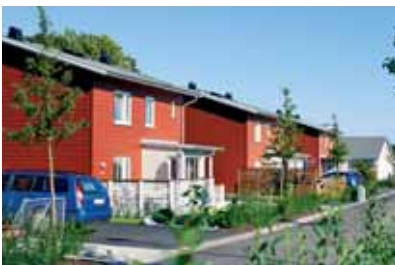
Passivhus i Vallda Heberg.
